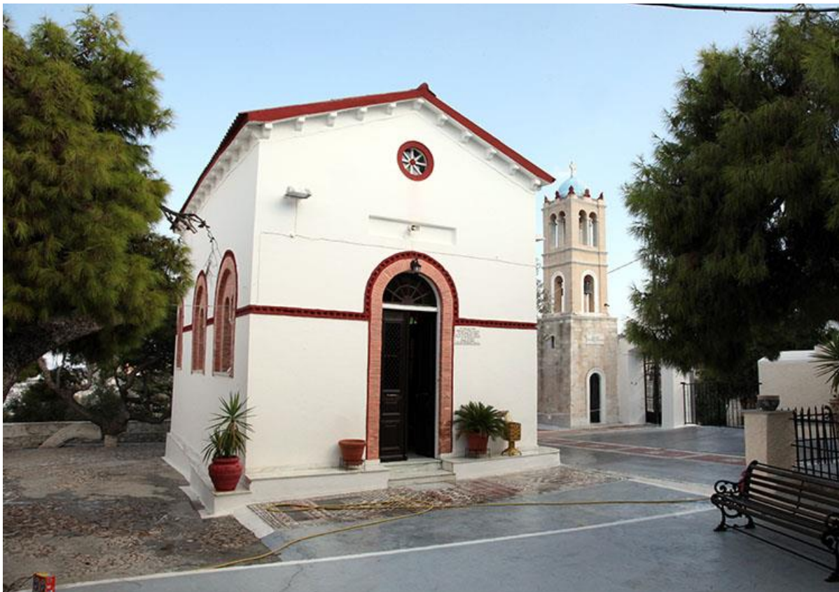
Εικ.4. Άποψη του Ιερού Ναού από το εσωτερικό της αυλής.
